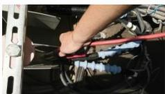
測試後，須確實放電，讓線路上的殘餘電壓能完全釋放。
