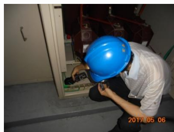
圖4 量接地電阻:確認接地良好
