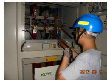
圖6 線路絕緣測試
