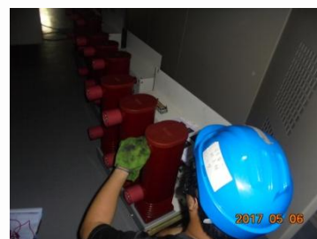
圖3 設備清潔:灰塵清除、污垢
