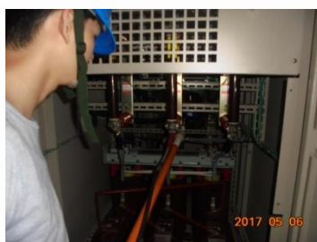
圖2 放電:線路殘電釋放
