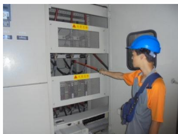
圖1 驗電:確認是否成功斷電
