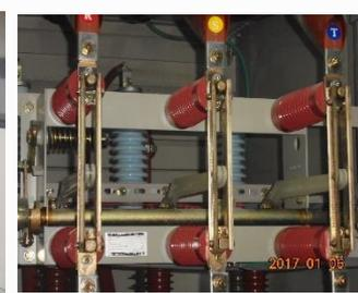
圖(四)夾三相接地線
